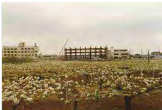
昭和 55 (1980) 年 4 月 24 日 建設中の稲城市役所
